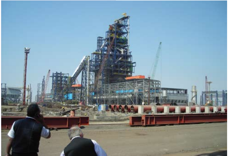
Estado de las obras de la nueva acería compacta
